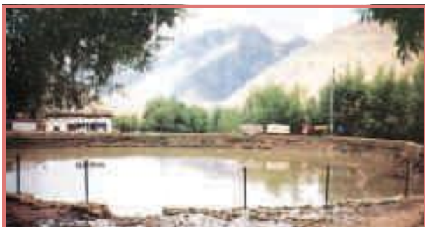
एक कुल से वर्तुल ग्रामीण तालाब बनता है (काजा गाँव के चित्र के अनुसार), जिससे जरूरत पड़ने पर पानी छोड़ सकते हैं।
